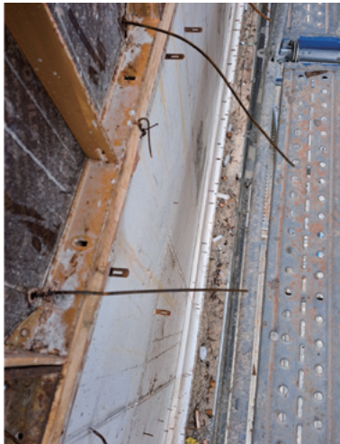
일부구간 외부 시스템비계 벽이음 설치 지연
